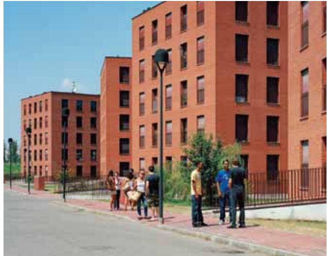
Maßgeschneiderte Lösungen, die staatliche Einrichtungen, Gemeinden und Universitäten dabei unterstützen, ihre Energieversorgung für ihre eigene Nutzung optimiert zu steuern
