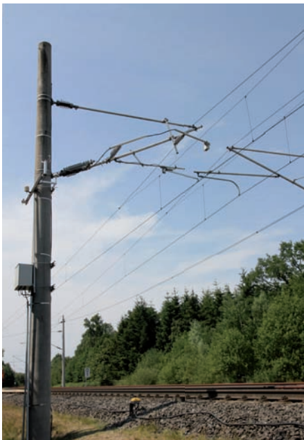
Sicat PMS, Prüfcenter Wildenrath, Deutschland
