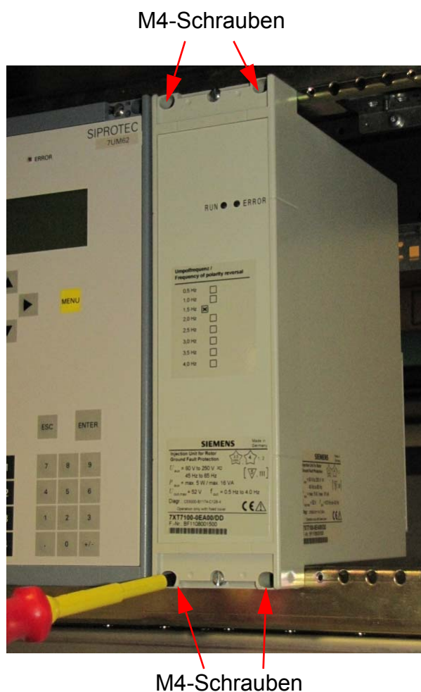
Bild 8-3 Einbau des Gerätes in die Schalttafel
