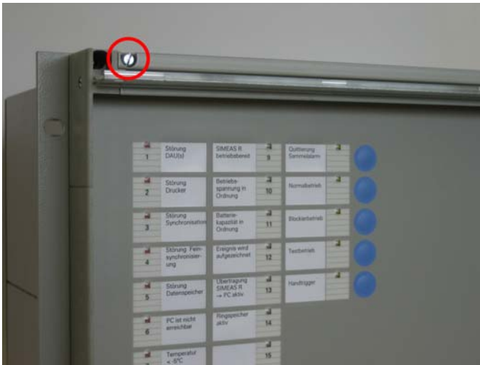
Abbildung 15: Abdeckrahmen entfernen
