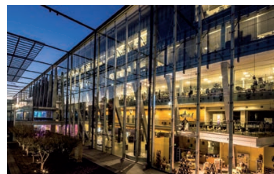
Gebäudemanagementplattform Desigo CC im Museum Victoria in Melbourne, Australien.
